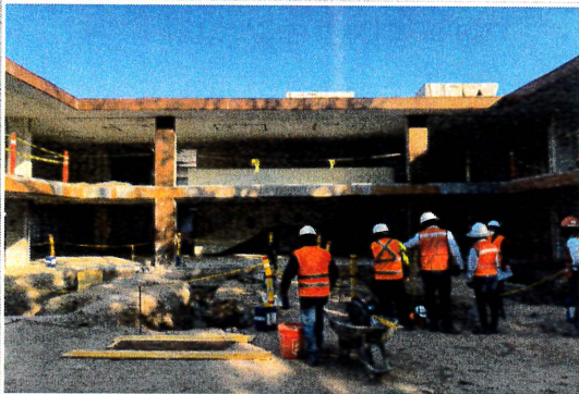
F1: Fachada principal
